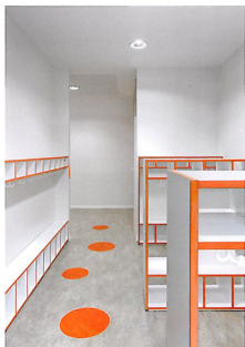
In eine Linoleumbodenfläche lassen sich sehr gut Intarsien einarbeiten
